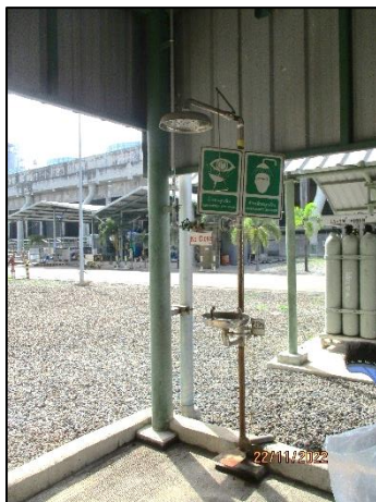
รูปที่ 2-49 ระบบ Safety Shower ภายในลานถัง
